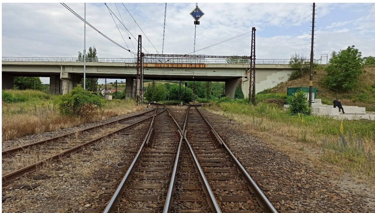
Obr. 5 Pohled na kolejovou spojku (výhybka č. 87 a č. 89)
